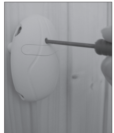
Figure 15. Reset button for overheating limiter Abbildung 15. Rücksetzknopf des Überhitzungsschutzes
