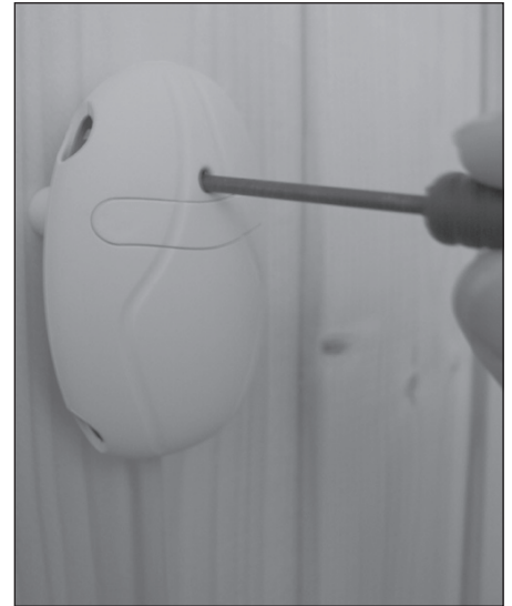
Kuva 15. Ylikuumentessuojan palautuspainike Bild 15. Återställning av överhettningsskydd
